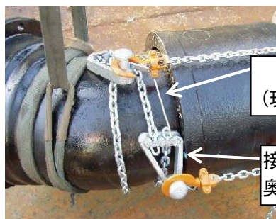
写真16—1 φ300異形管の接合時①
