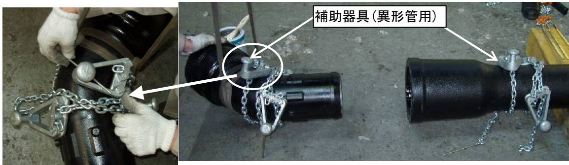
写真5 異形管(3点引き)のときの接合器具の取り付け方法
