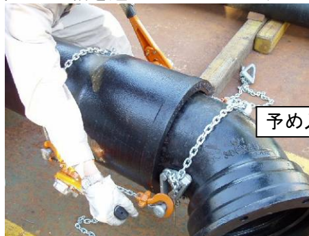
写真16—3 φ300異形管の接合時③
