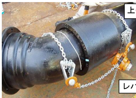
写真16—2 φ300異形管の接合時②
