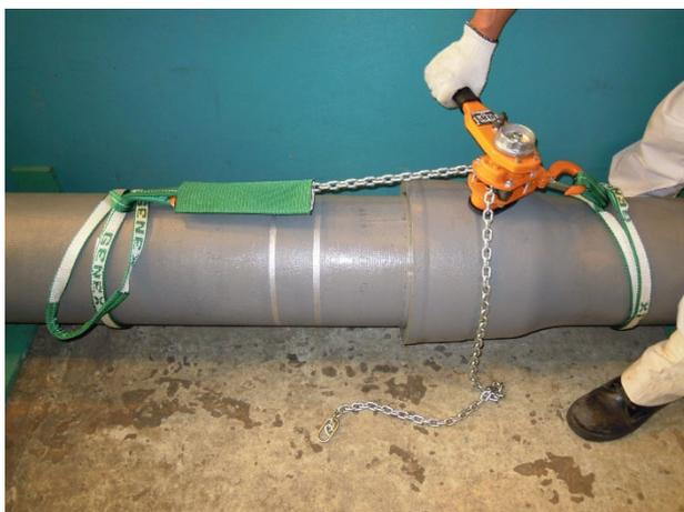
写真4 1点引きによる直管の接合（呼び径 250）
