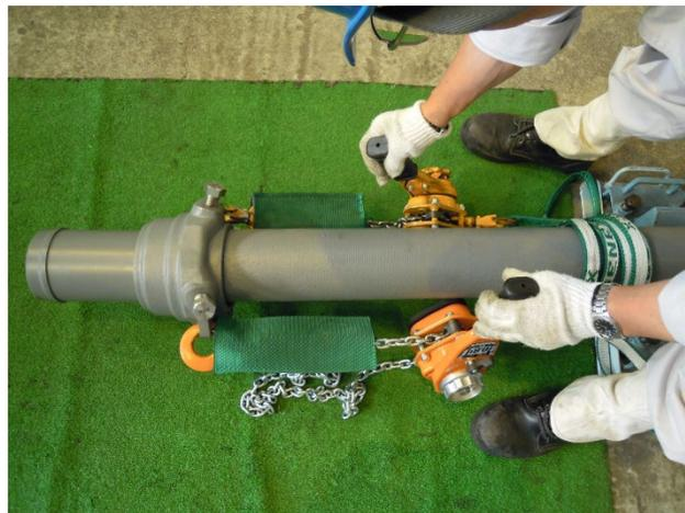
写真9 P-Linkの取り付け（呼び径100）
