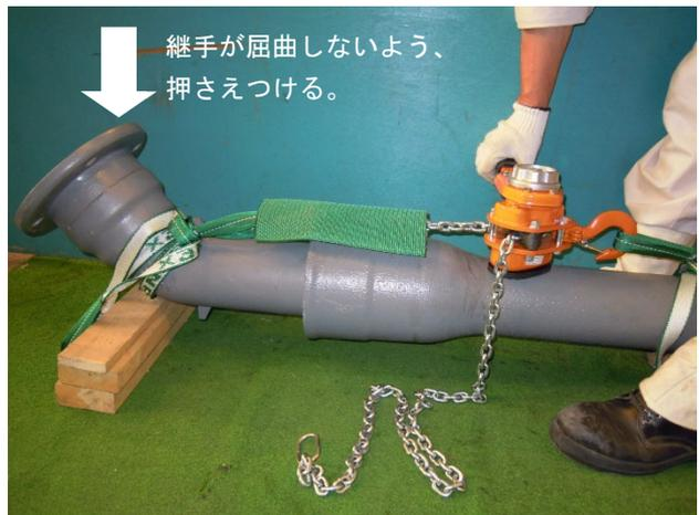
写真7 1点引きによる異形管の接合
