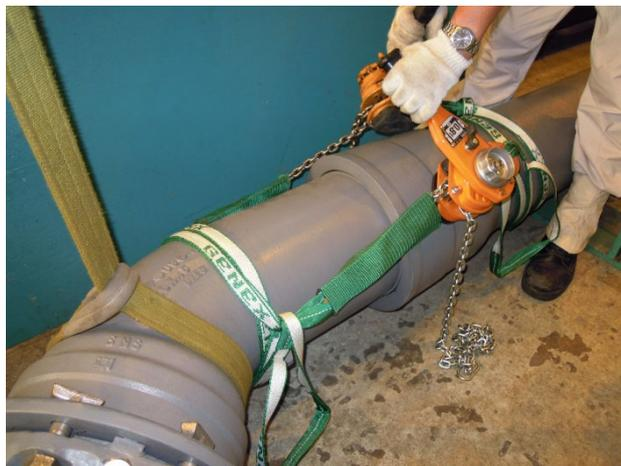
写真6 2点引きによる異形管の接合
