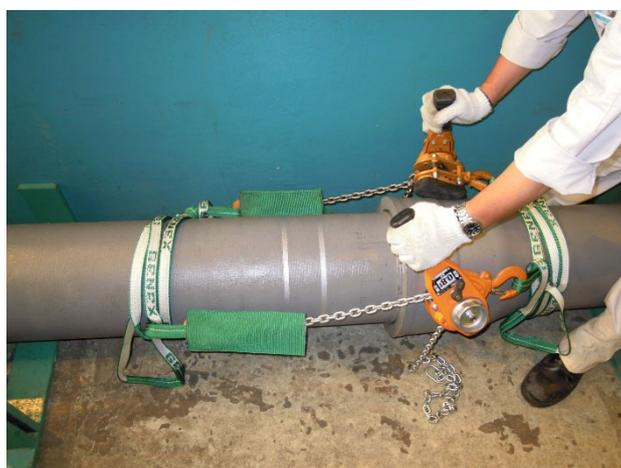
写真5 2点引きによる短管の接合（呼び径 250）
