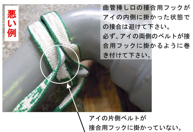
写真8 曲管挿し口へのGX形スリングベルト巻き付け例（呼び径75）
