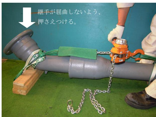
写真6 1点引きによる異形管の接合
