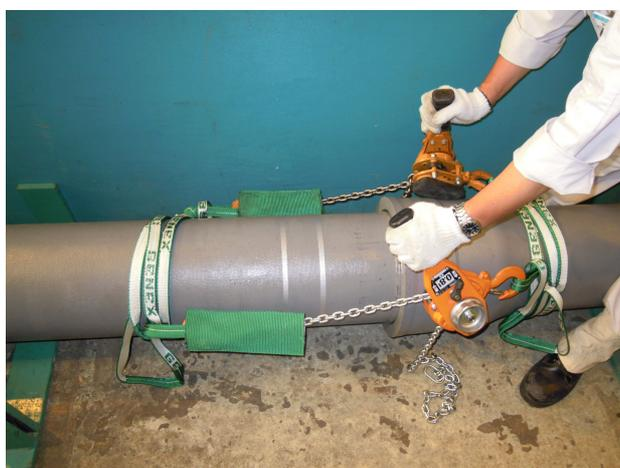
写真4 2点引きによる短管の接合（呼び径 250）
