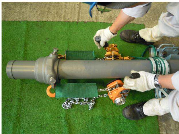
写真7 P-L i n kの取り付け（呼び径100）
