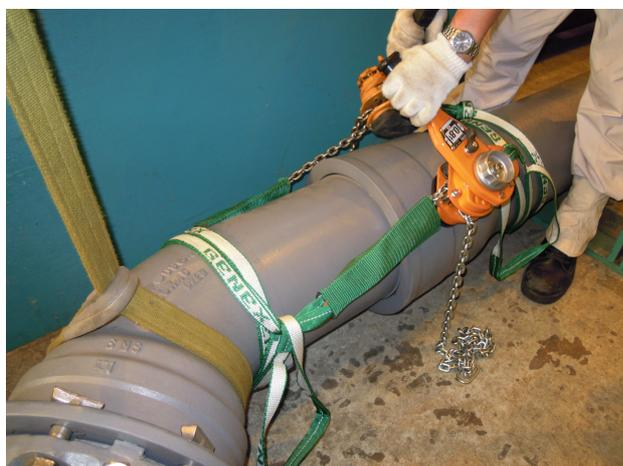
写真5 2点引きによる異形管の接合
