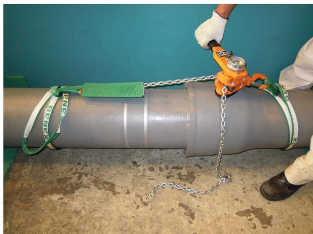
写真3 1点引きによる直管の接合（呼び径 250）
