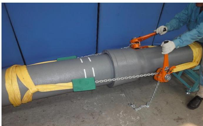
写真4 2点引きによる短管の接合
