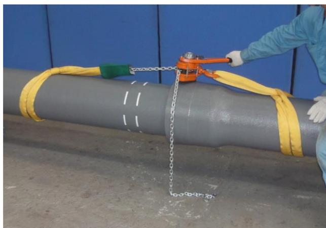
写真3 1点引きによる直管の接合
