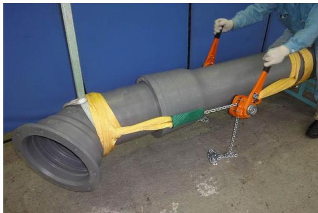
写真5 2点引きによる異形管の接合
