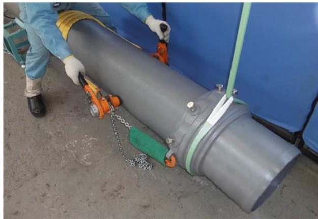
写真7 P-L i n kの取り付け（呼び径 300）
